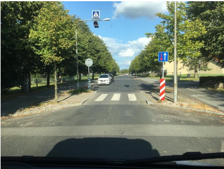
Bild 1: Verengung der Fahrbahn auf eine Spur
